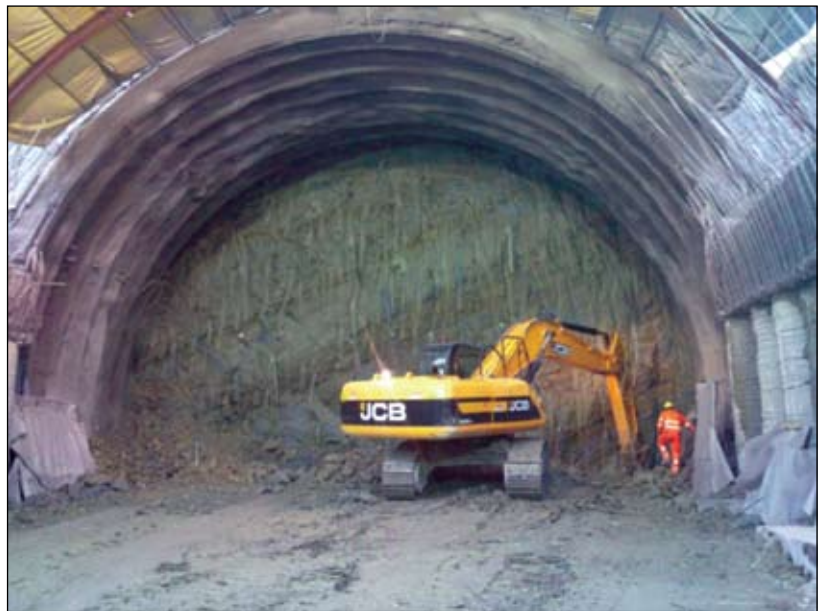
Разработка грунта у лба забоя
