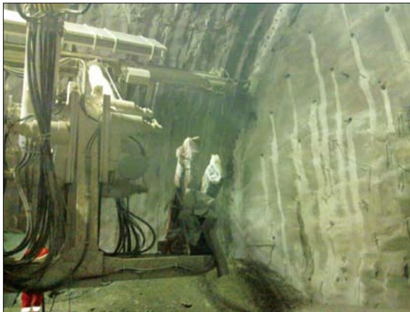
Realizzazione consolidamenti al fronte
