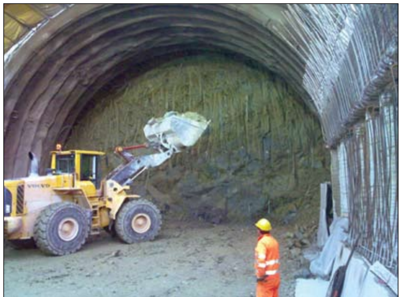
Оборка забоя и вывоз грунта
